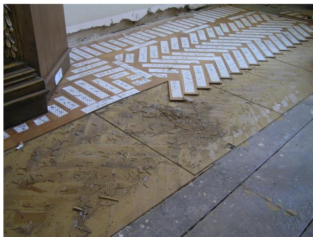
Afb. 17 en 18: Het maken van schetsen en het identificeren en vastleggen van de locatie van de uit te nemen onderdelen, voorafgaand aan werkzaamheden, is essentieel. Ieder plankje of strook krijgt een eigen identificatienummer. Het is belangrijk dat de codering geen visuele aantasting achterlaat op het hout.
