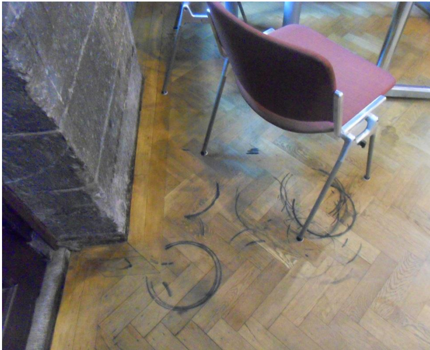
Afb. 30: Zwarte kringen in de eiken parketvloer als gevolg van de reactie tussen een metalen vuilnisemmer, vocht en het in eikenhout aanwezige looizuur. Schade had voorkomen kunnen worden door het dweilen te beperken, een bescherming onder de vuilnisemmer te plaatsen of een kunststof vuilnisemmer te gebruiken.
