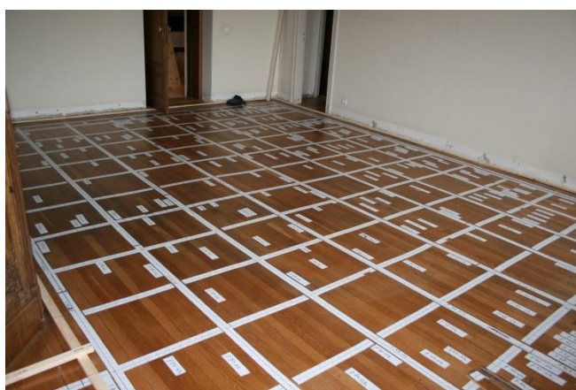
Afb. 19 en 20: Identificeren en vastleggen van de locatie van de uit te nemen onderdelen, voorafgaand aan werkzaamheden. Ieder plankje of strook krijgt een eigen identificatienummer. Het is belangrijk dat de codering geen visuele aantasting achterlaat. Soms wordt gebruik gemaakt van een laser voor het uitzetten van de lijnen.
