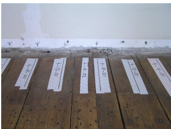
Afb. 19 en 20: Identificeren en vastleggen van de locatie van de uit te nemen onderdelen, voorafgaand aan werkzaamheden. Ieder plankje of strook krijgt een eigen identificatienummer. Het is belangrijk dat de codering geen visuele aantasting achterlaat. Soms wordt gebruik gemaakt van een laser voor het uitzetten van de lijnen.
