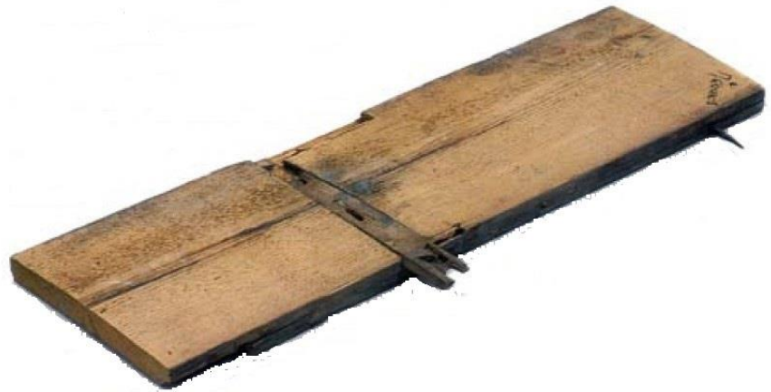
Afb. 12: Onderaanzicht van een zeventiende-eeuwse plank. Links van het midden is een wig zichtbaar, die op de balk gespijkerd wordt. Door de plank over de wiggen te schuiven wordt de plank, 'blind' en zonder te spijkeren, aan de balken bevestigd.
