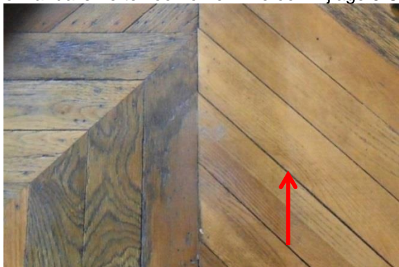
Afb. 13: Lichtschade, met aftekening tapijtrand.
