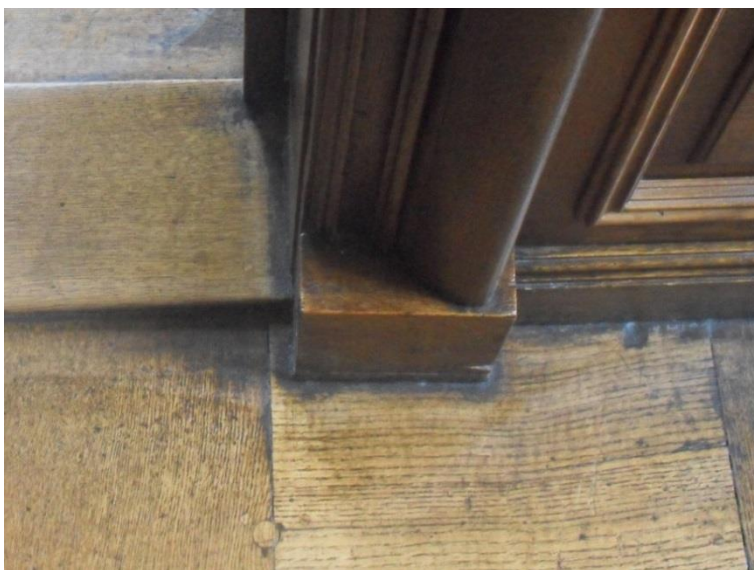
Afb.24: Vooral op moeilijk te bereiken plaatsen en weinig belopen vloerdelen bevinden zich vaak zwarte resten boenwas.
