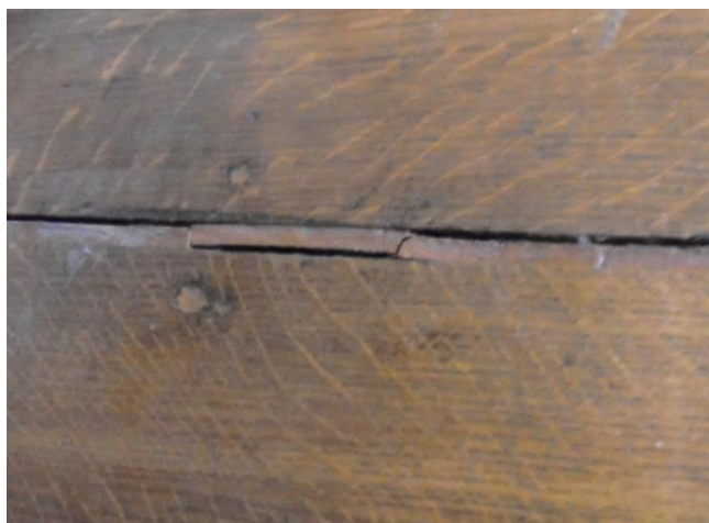
Afb.26: Losgekomen 'uitgedroogd' vulmiddel tussen twee vloerplanken.
